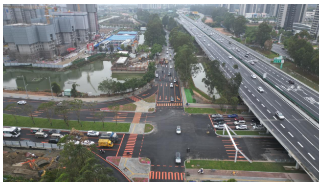
华南地区断面最大顶管隧道工程 双向全线顺利通车
