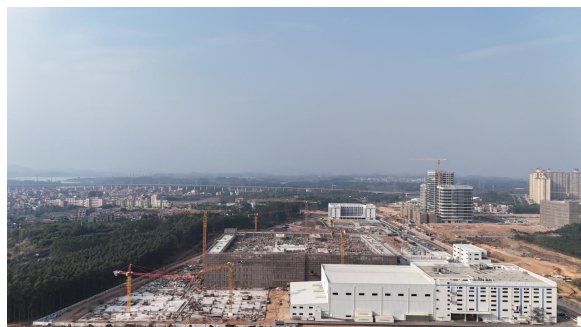
现场工程进度照片
