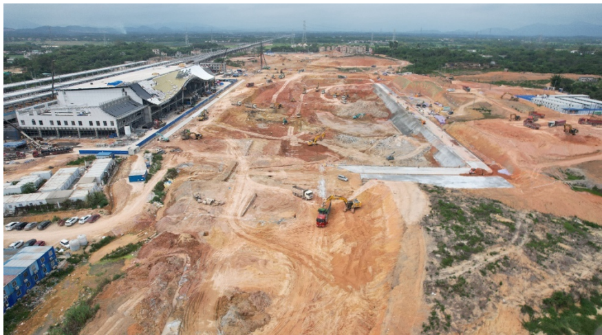
广湛高铁阳江北站智能交通枢纽工程
