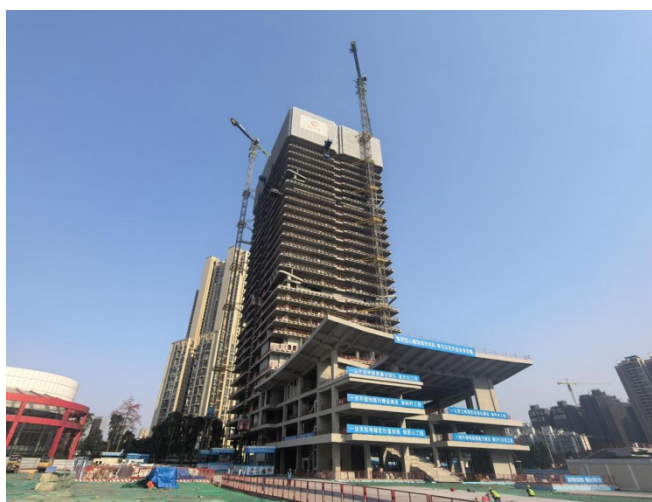
省重点文化产业项目“小羊楼” 主体结构顺利完工
